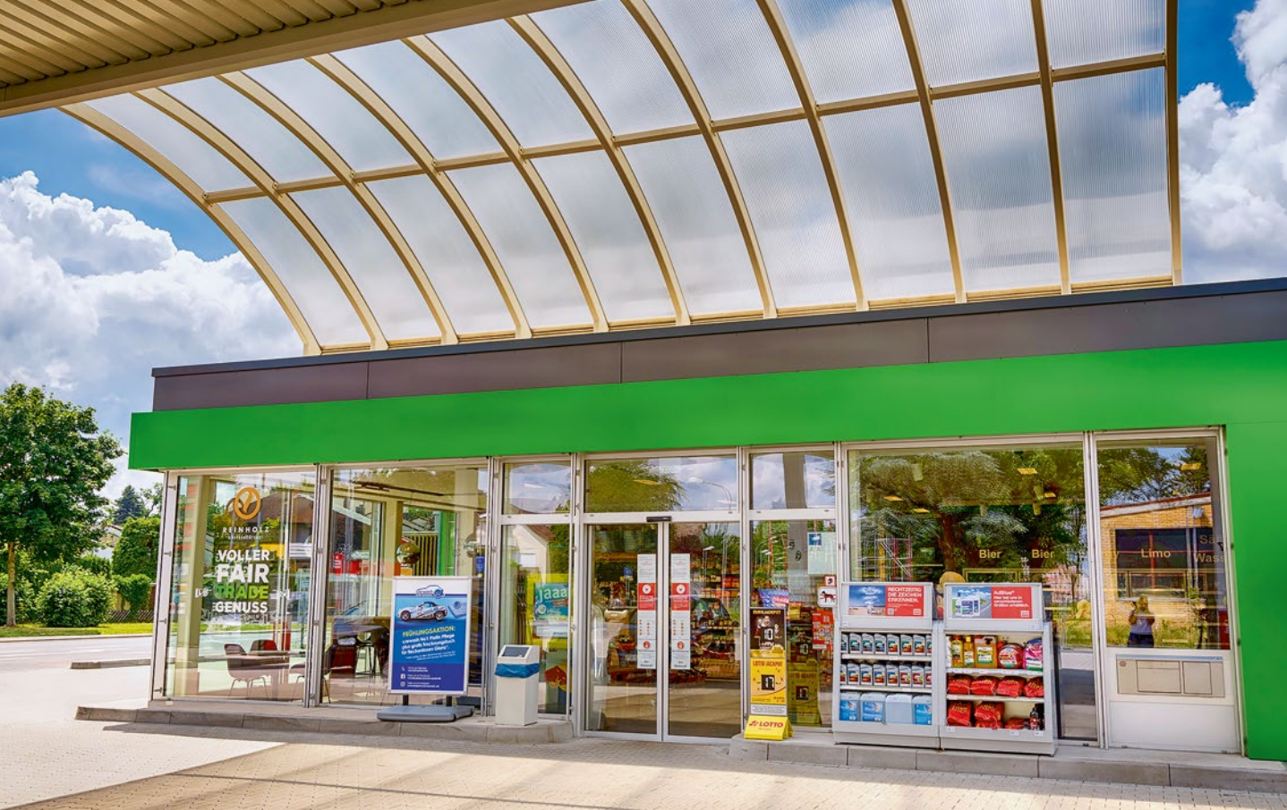
Hell, freundlich und einladend präsentiert sich das Shopkonzept Greenbox den Tankstellenkunden schon auf dem Forecourt.
