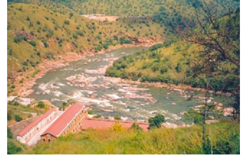
Das Laufwasserkraftwerk in Karnataka in Indien nutzt die natürliche Fließgeschwindigkeit des Flusses, so dass keine schädlichen Eingriffe in die Umwelt, etwa durch den Bau eines Staudamms oder Stausees, nötig sind.
